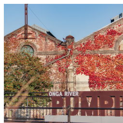
遠賀川水源地ポンプ室
